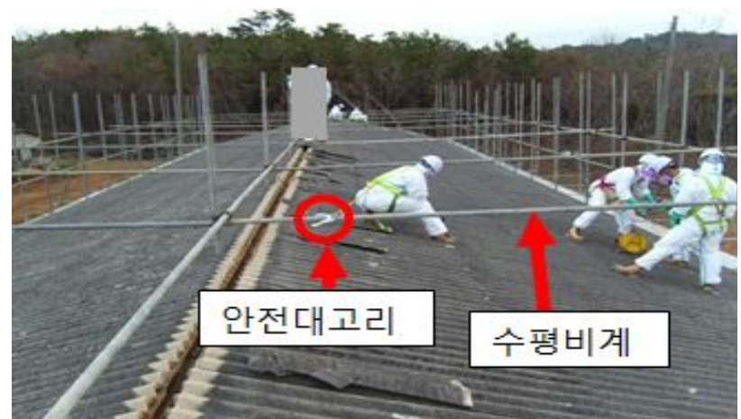
지붕 위 수평비계 설치(예)
